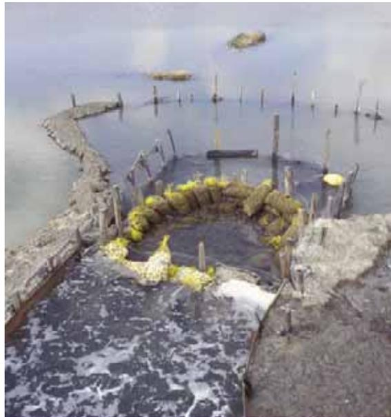
Dispositif de filtration à base de coquilles d'huître, plumes et pouzzolane\* à l'entrée d'une vasière
